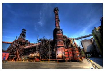
Die bestehende Midrex-Anlage am Hamburger Produktionsstandort ist diejenige mit dem geringsten CO<sub>2</sub>-Ausstoß für die Qualitätsstahlproduktion in Europa. Jährlich werden 980.000 Tonnen Eisenerzpellets zu Eisenschwamm verarbeitet, der zu 95 Prozent aus reinem Eisen besteht.
